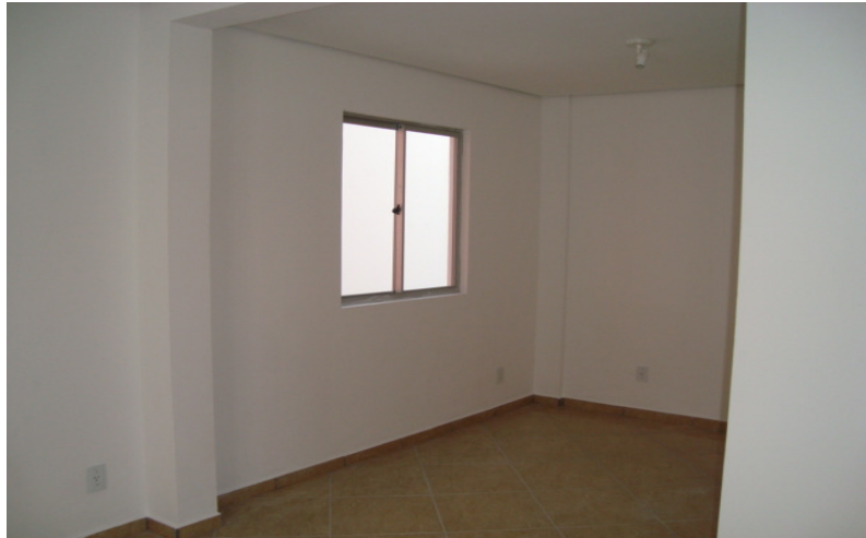
Figura 3.1 - Logo após os apartamentos serem entregues, a parede do dormitório foi demolida para se integrar à Sala de Estar . Fonte: arquivo do Autor.
