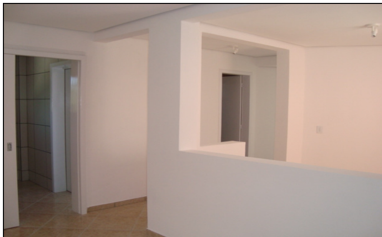
Figura 1 - Logo após os apartamentos serem entregues, as paredes do dormitório foram parcialmente demolidas para se integrar à Sala de Estar e a porta de abrir da Cozinha foi substituída por uma porta de correr.
