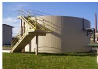
**Fig. 54** - Adensador de lodo
