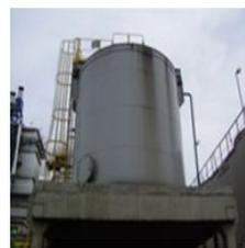
**Fig. 26 – Tanque homogeneizador**
