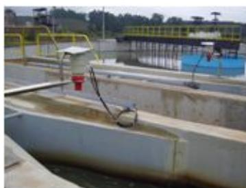
**Fig. 53** - Calhas com medidores de vazão
