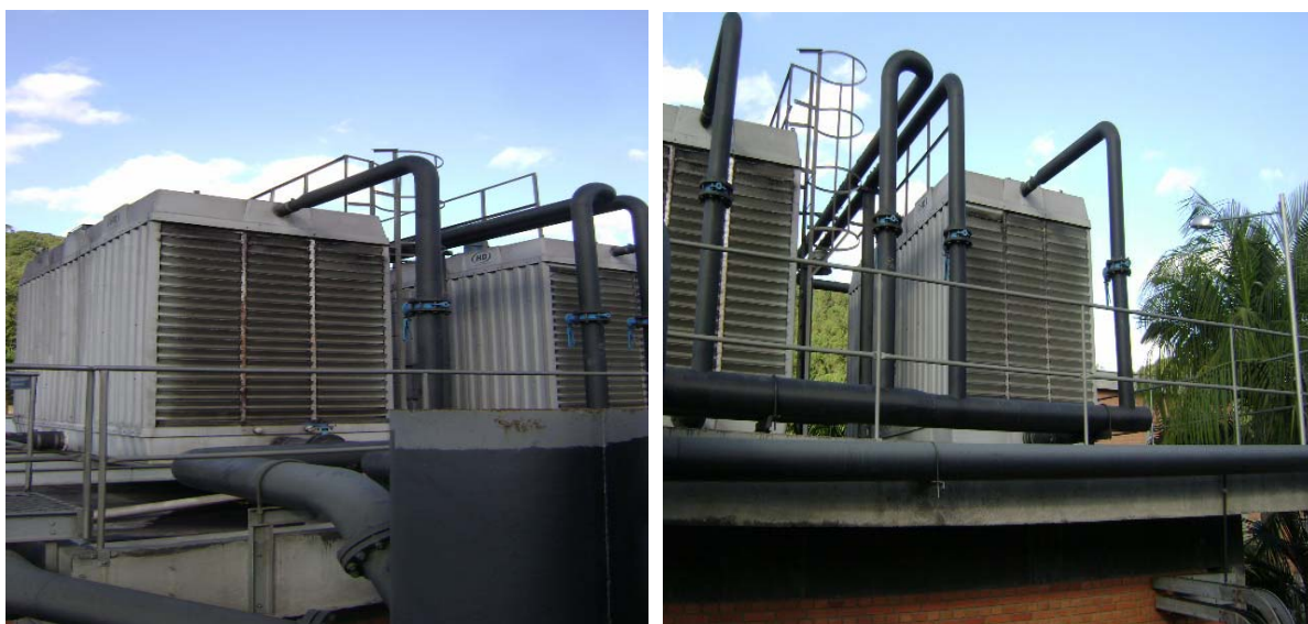
Torres de Resfriamento da Estação de Tratamento de Efluentes Fonte: Coteminas S/A
