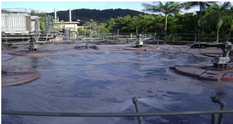
Reator Biológico da ETE Fonte: Coteminas S/A
