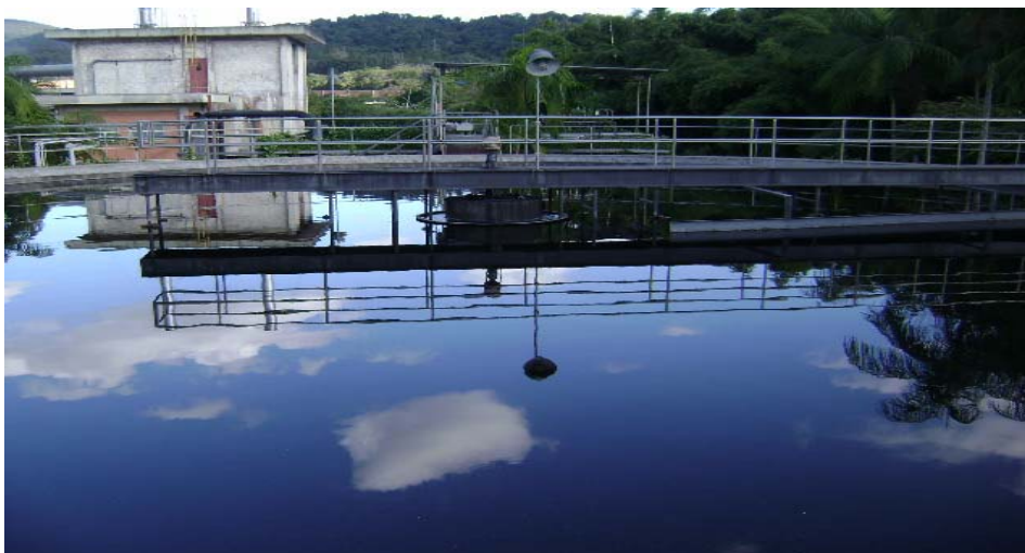
Decantação físico-químico da ETE
