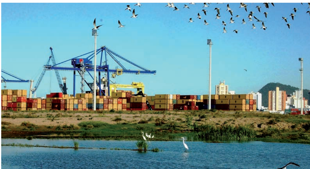
Preservação da fauna e da flora locais é uma das metas do SGA da Portonave
