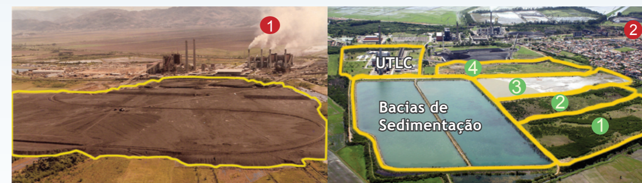
Imagem 1: área do pátio da Caeeb nos anos 80 Imagem 2: área em processo de recuperação (foto de nov/2005) No pátio foram construídas a usina UTLC, duas bacias de sedimentação em ciclo fechado, e recuperadas as áreas correspondentes às bacias
