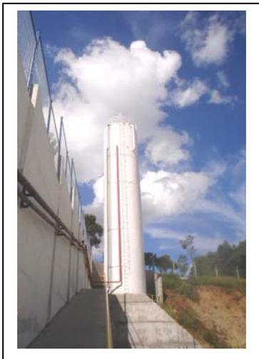
A foto ao lado evidencia o reservatório confeccionado com chapas metálicas com volume disponível de 750.000 litros de água da chuva e a cisterna foi confeccionada em alvenaria com capacidade de 250.000 litros de água da chuva.
