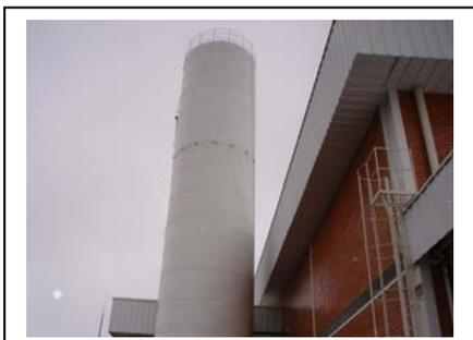
A foto ao lado evidencia o segundo reservatório de água da chuva, também confeccionado em chapas metálicas com capacidade de 480.000 litros de água da chuva e cisternas com 210.000 litros, 30.000 litros e 450.000 litros.
