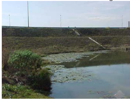
FIGURA 17 - Talude do entorno dos lagos.
