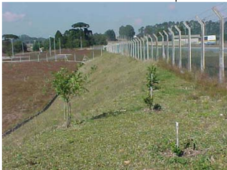
FIGURA 12 - Talude na divisa da empresa com a rua.
