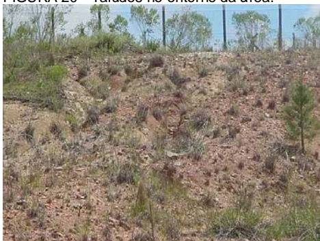
FIGURA 20 - Taludes no entorno da área.
