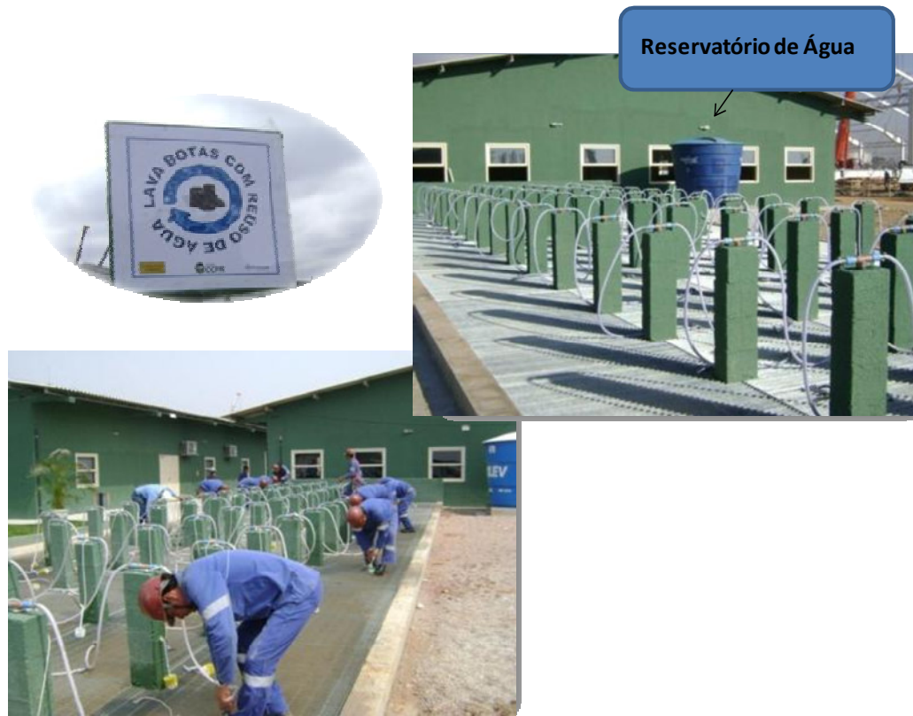
Figura 9 - Lava botas instalado na área 12
