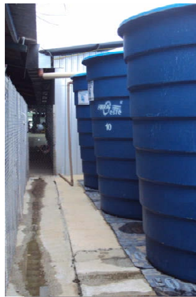
Figura 11 - Vista das caixas utilizadas para armazenamento da água captada e detalhe da captação utilizada
