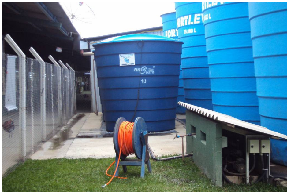
Figura 10 - Vista Geral do sistema de captação de água e bomba de pressurização
