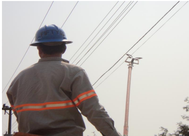
Figura 07: Separadores sendo colocados para evitar a reconstrução dos ninhos. (2010)
