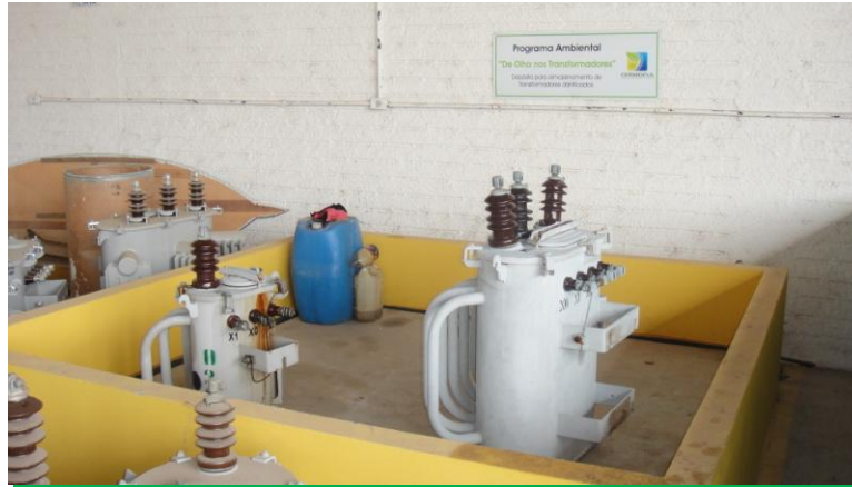
Figura 05: Depósito de transformadores danificado. (2010)
