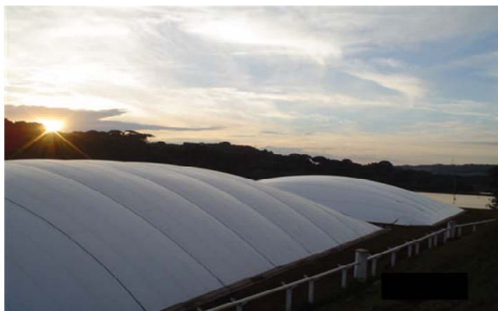
Imagem 5: Biodigestores utilizados para captação do biogás na Granja São Roque I.
