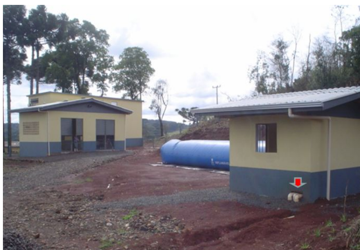
Imagem 6: Central de Gás (à direita), Central de Geração (à esquerda, à frente) e Central de Distribuição (à esquerda, atrás)
