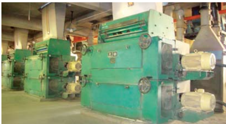
Quebradores da área de Preparação
