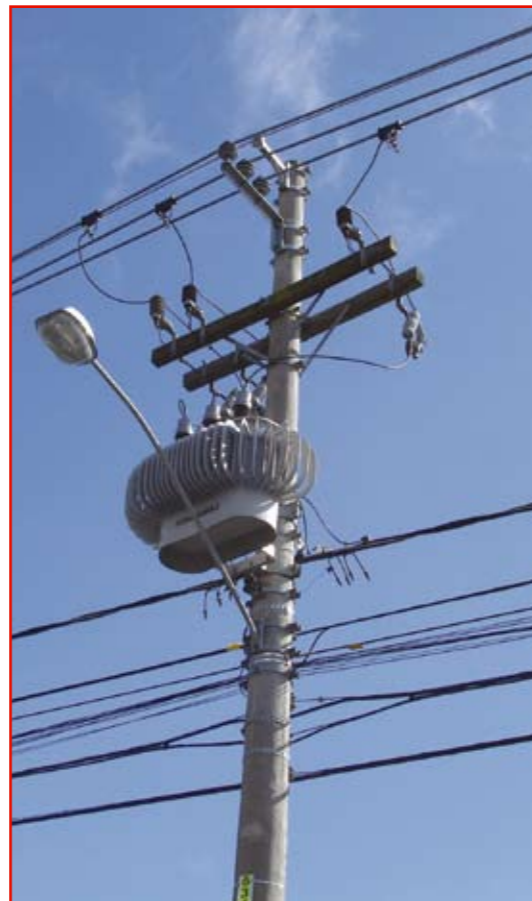
Nessa obra, o uso da cruzeta beco evitou a necessidade de intervenções na vegetação.
