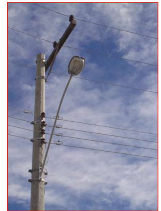
Rede com sistemas convencionais de alta (parte superior) e baixa tensão, os quais ocupam mais espaço devido à necessidade de existir maior afastamento entre cabos.
