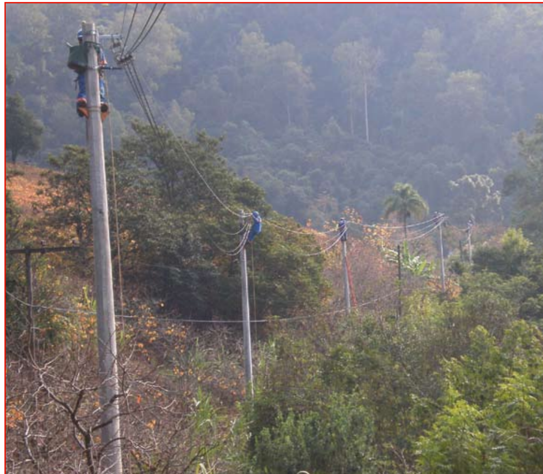
Fiscalização da execução de instalação de rede compacta em área com forte presença de vegetação.
