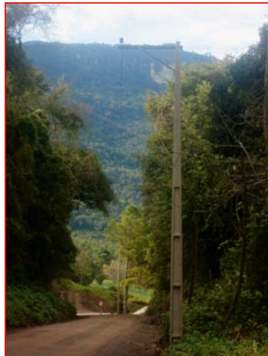
Nessa obra, o uso da cruzeta beco evitou a necessidade de intervenções na vegetação.
