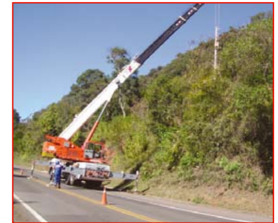
Além das diretrizes contratuais, eventualmente são adotadas outras medidas de preservação, tais como o uso de guindastes para a colocação de postes, que evita a abertura de acessos e danos na vegetação.
