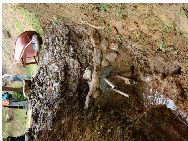
Montagem do sistema de captação de água - Caxambu
