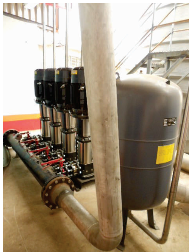
Bombas Central de Higienização.
