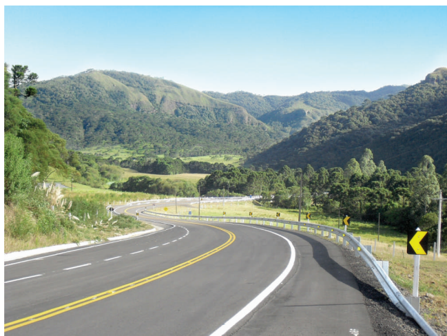
SC 370 Urubici - Grão Pará Obra de pavimentação (Concluída em 2012)
