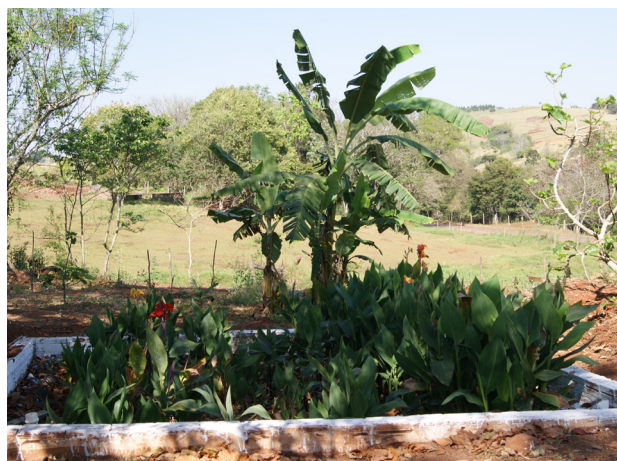
Estação de tratamento de esgotos. detalhe para o plantio de bananeiras ao fundo.
