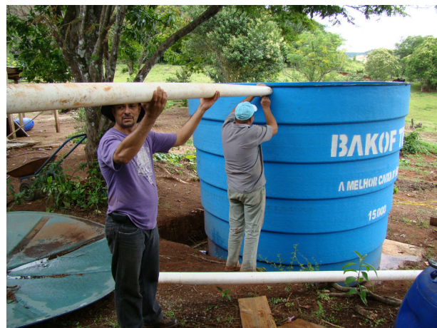
Montagem do sistema de captação da água da chuva
