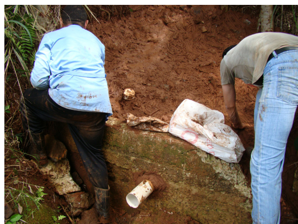
Recuperação e proteção da nascente da escola
