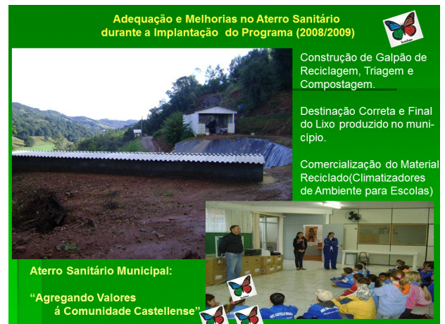
Adequação e melhorias no Aterro Sanitário durante a implantação do programa
