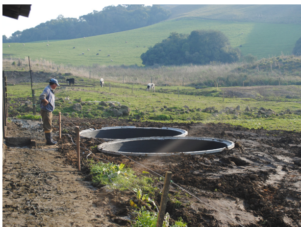
Instalação de esterqueira para tratamento dos dejetos dos animais
