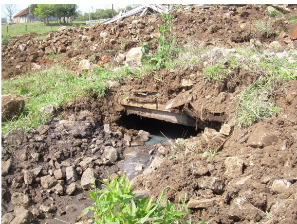
Forma inadequada do destino das águas servidas
