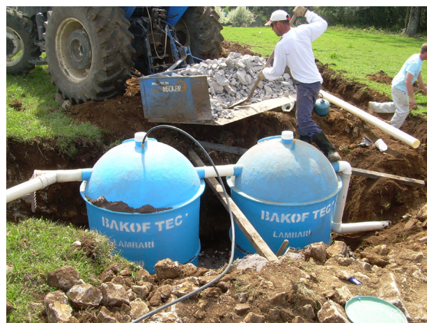
Instalação de sistema de tratamento das águas servidas (caixa de gordura, fossa séptica, filtro anaeróbico e sumidouro)
