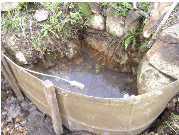
Fonte de água utilizada para consumo humano sem proteção
