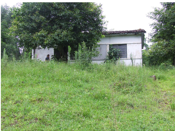
Escolinha desativada antes da reforma
