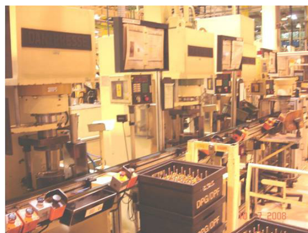
Antes - Prensas hidráulicas utilizadas na montagem de motor DPG
