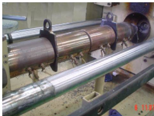
Máquina injetora antes da instalação da manta térmica
