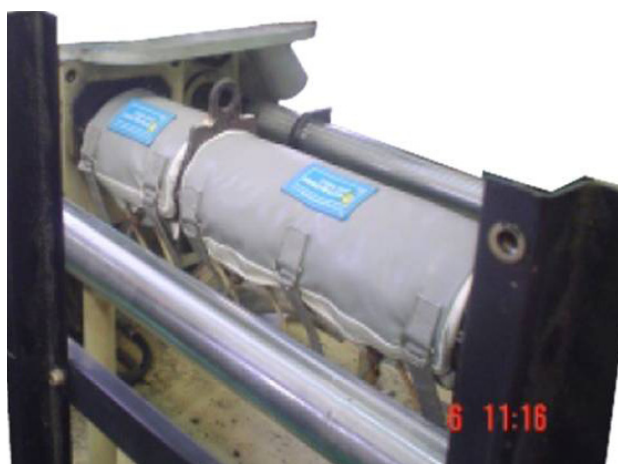
Máquina injetora após a instalação da manta térmica
