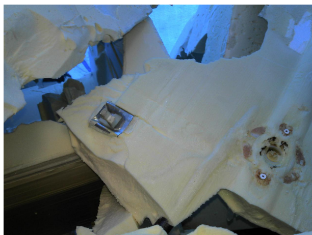
Poliuretano com contaminações
