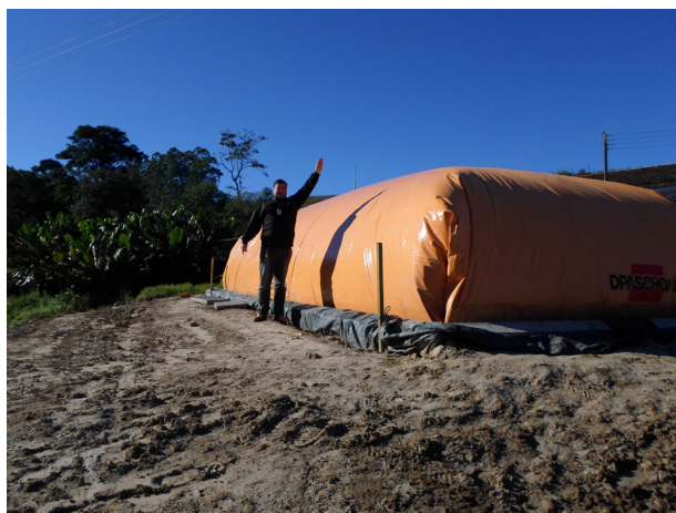
Biodigestor Ampliado com balão cheio
