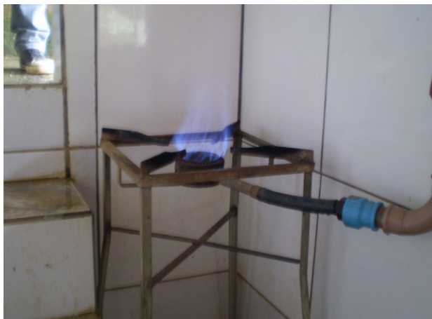
Biogás sendo utilizado na sala de ordenha
