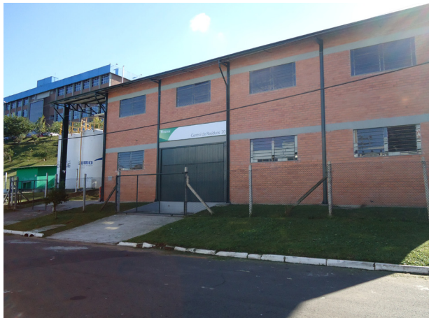
Central de Resíduos
