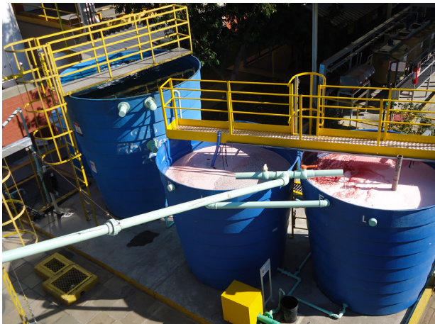
Reservação de efluentes
