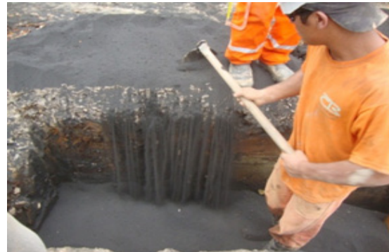
Uso da ADF em assentamento de tubos
