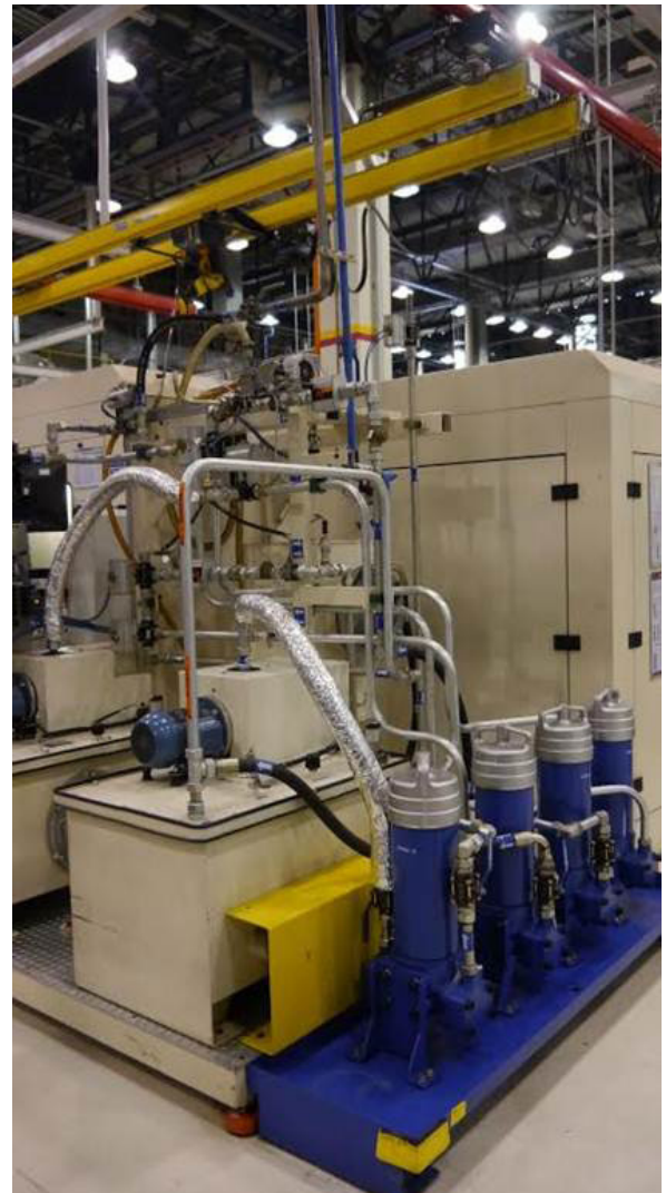
Equipamento de aquecimento de óleo com modo de espera
