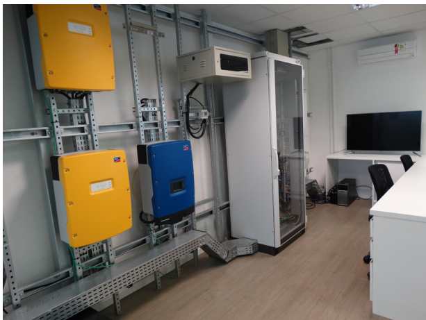
Usina parte interna
