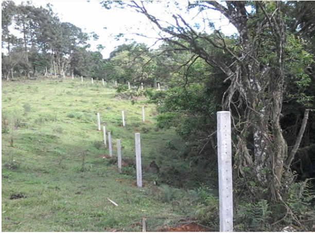
Instalação das cercas para isolamento da mata ciliar
