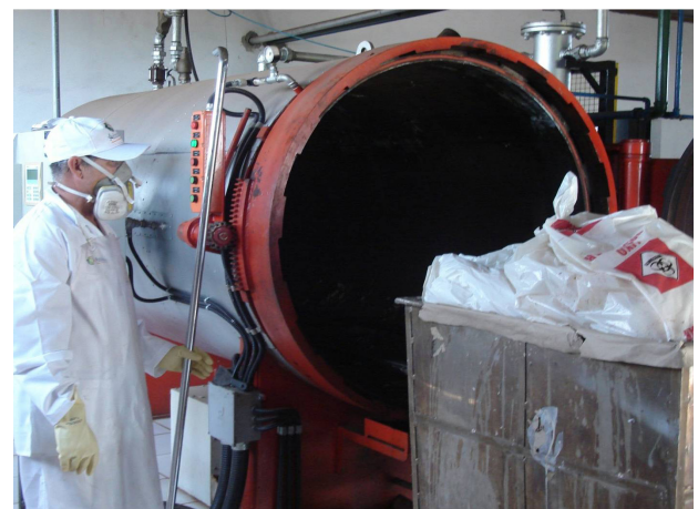
Autoclavagem dos resíduos de risco biológico: resíduo é triturado e disposto em aterro
