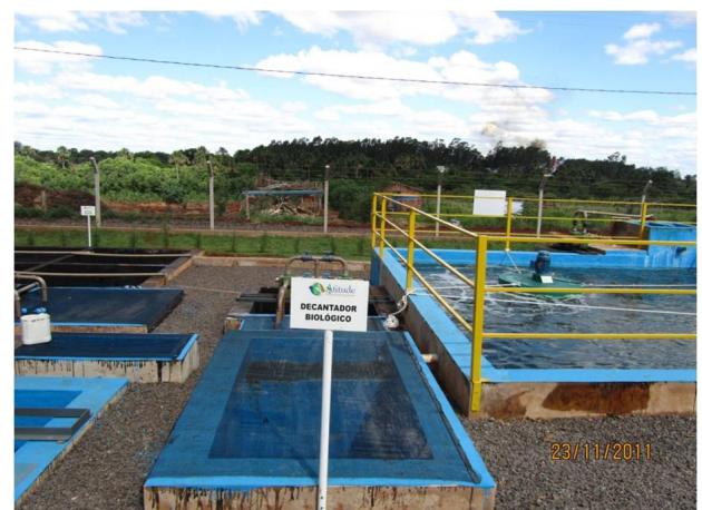
Tratamento de Efluentes é realizado na unidade da Atitude Ambiental em Campo Grande
