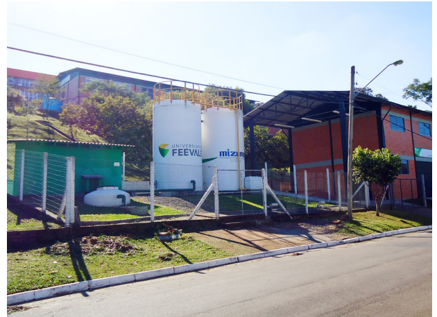
ETE e Central de Resíduos
