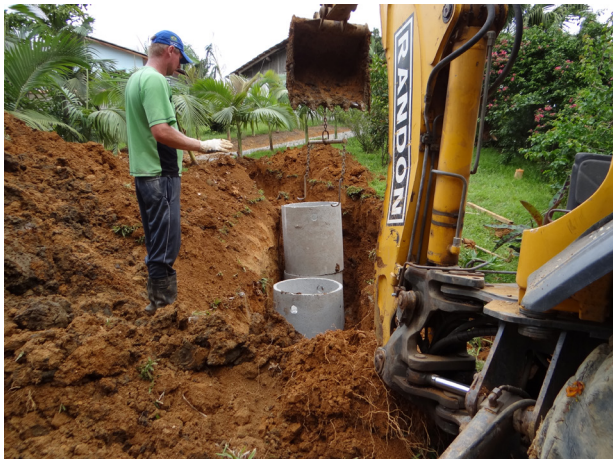
Instalação das fossas com filtro
