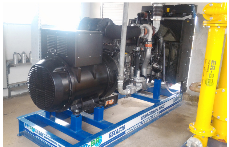
Gerador a biogás 330kVA
