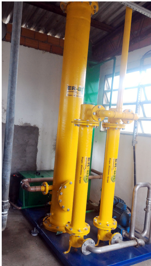
Usina de tratamento de biogás
