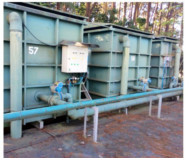
Sistema de filtros da água da chuva
