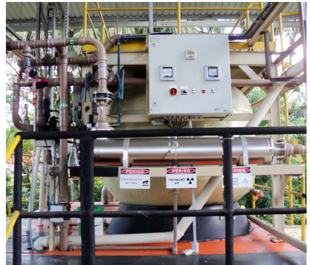
Detalhe do sistema de desinfecção UV do processo de reuso
