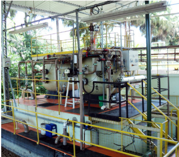
Filtros do sistema de reuso
