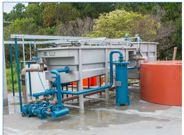
Unidade instalada dentro do Sapiens Parque faz o tratamento-filtragem da água poluída do rio, devolvendo-a mais limpa ao próprio rio
