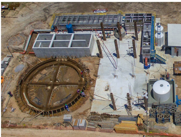
Nova ETE em Canasvieiras em execução
