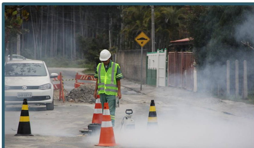
Videoinspeção (microfilmagem com robô) em 42 quilômetros de rede em Canasvieiras e Cachoreira do Bom Jesus encontradas 56 ligações clandestinas
