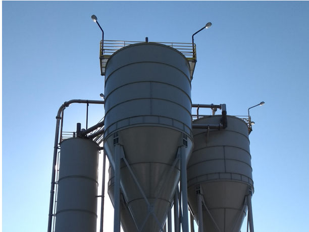
Ampliação estação de tratamento de efluentes
