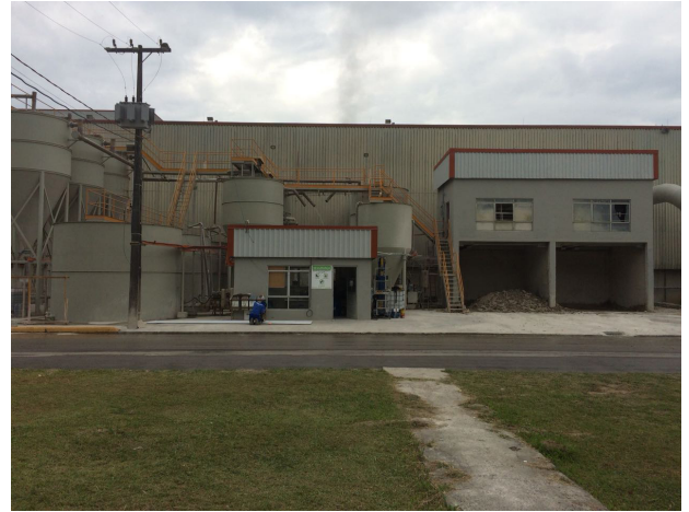
Ampliação estação de tratamento 02
