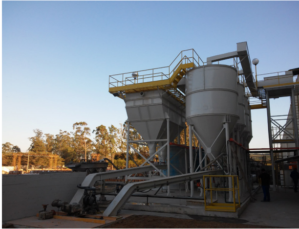
Ampliação estação de tratamento 01
