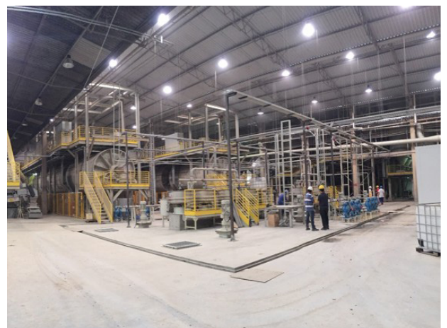
Setor de massa com ampliações concluídas
