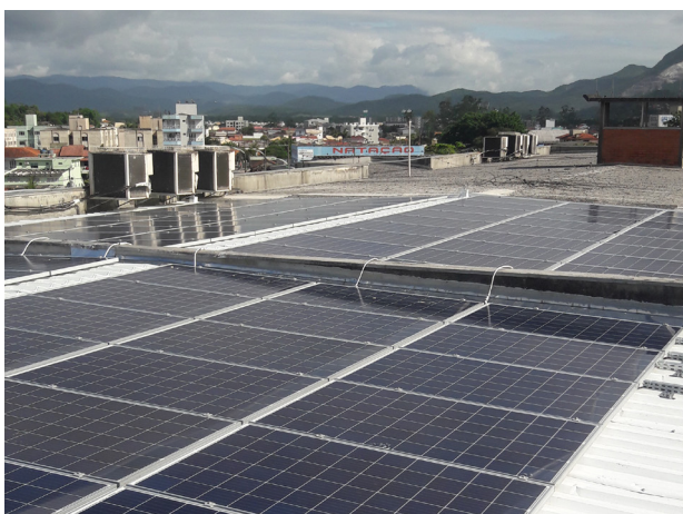
sistema fotovoltaico instalado
