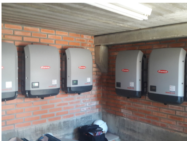
Inversores instalados
