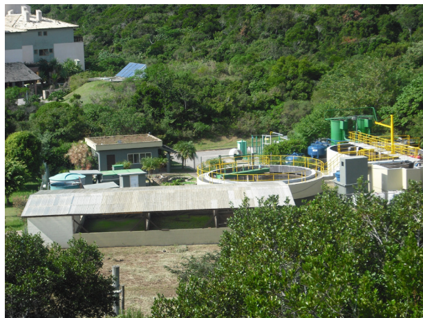
Moderna Estação de Tratamento de Efluentes
