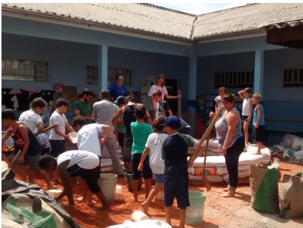
Construção da praça literária
