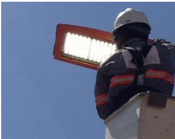
Instalação das novas luminárias em Taquara
