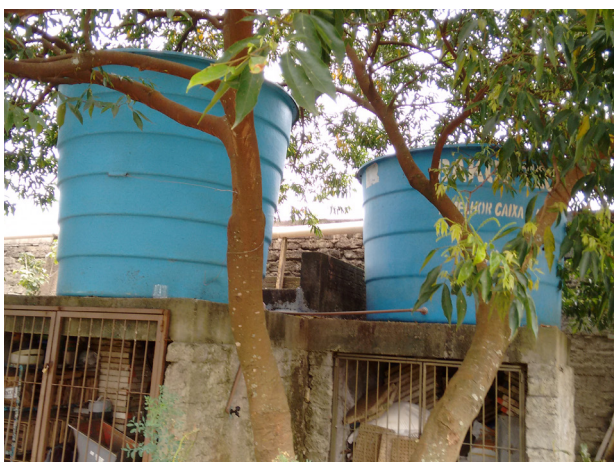
Reservatório de água armazenada da chuva
