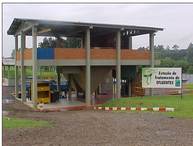
Estação de Tratamento de Efluentes AGCO Santa Rosa
