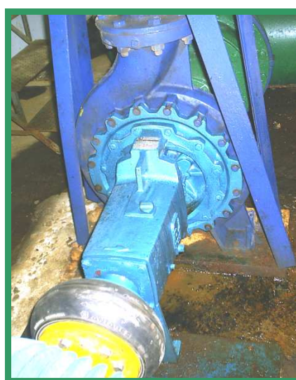
Figura 6. Voluta da bomba (recondicionada)
