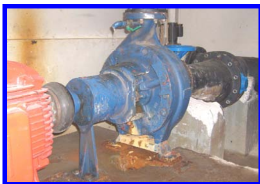
Figura 11. Detalhe da voluta da bomba 1 (antes)
