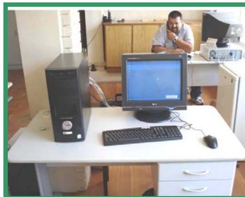
Figura 22. Estação central de supervisão e controle – Parque da Imprensa
