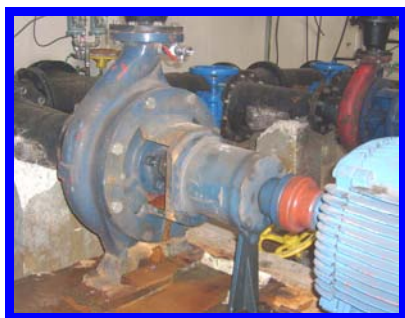
Figura 13. Detalhe da voluta da bomba 2 (antes)
