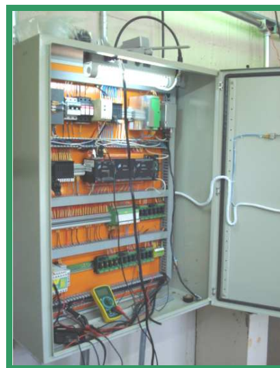
Figura 20. Estação mestre de automação – Parque da Imprensa
