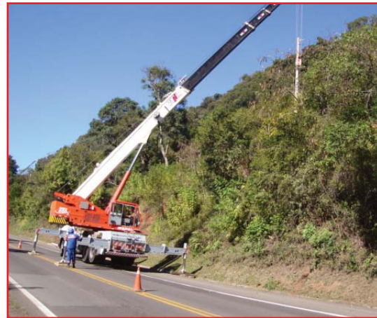
Além das diretrizes contratuais, eventualmente são adotadas outras medidas de preservação, tais como o uso de guindastes para a colocação de postes, que evita a abertura de acessos e danos na vegetação.
